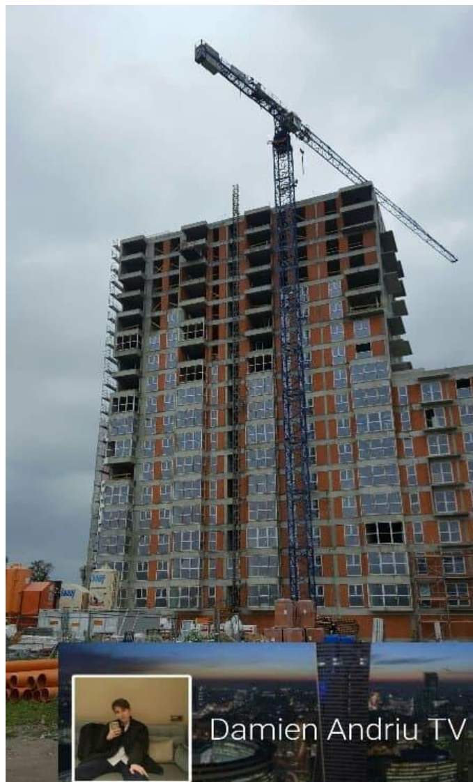
DAMIEN ANDRIU TV ***Budowa I etapu osiedla Omulewska 26- sierpień 2018
